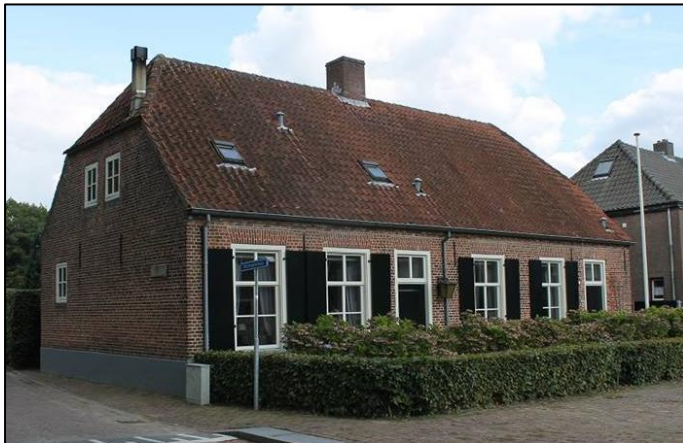
In dit pand aan de Molenstraat was van 1830 tot 1870 de eerste Riethovense school gehuisvest.
